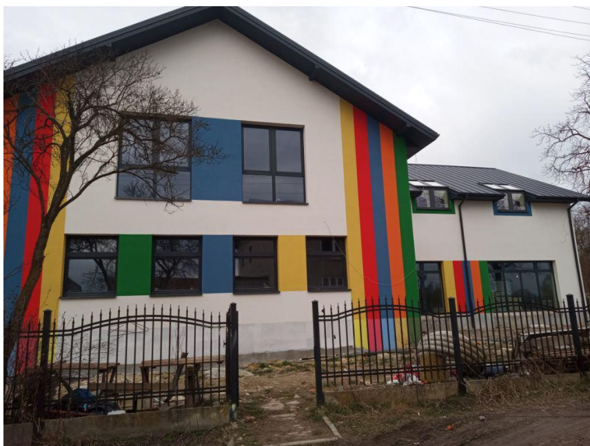
Budowa obiektu przedszkolno-żłobkowego w Promniku.
