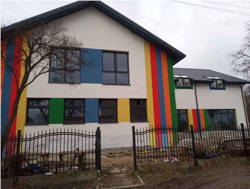
Budowa obiektu przedszkolno-żłobkowego w Promniku.
