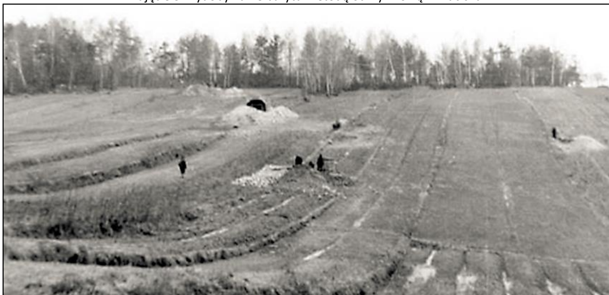
Zdjęcie 3 Wydobywanie barytu metodą odkrywkową w Hucisku.
